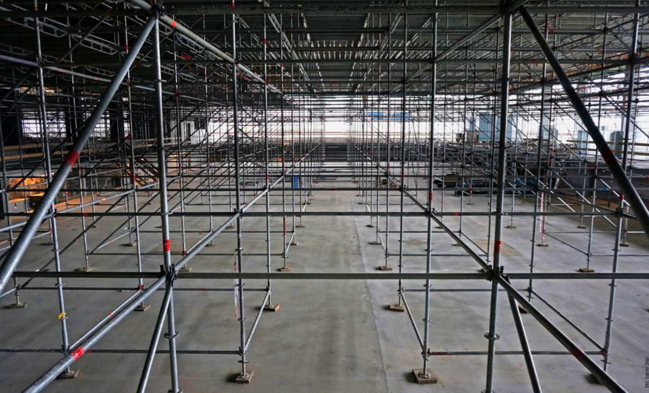
Noch ist das neue 50-Meter-Becken erst eine gewaltige Betonwanne. Doch bereits Ende Jahr werden hier Wettkampf- und Hobbyschwimmer ihre Längen ziehen (Visualisierung unten).
